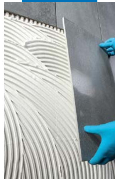
Aanbrengen van grootformaattegels op lichtgewicht betonblokken
