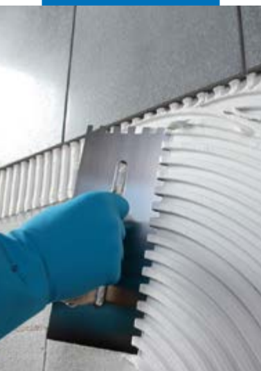
Ultramastic 5 op de ondergrond aanbrengen
