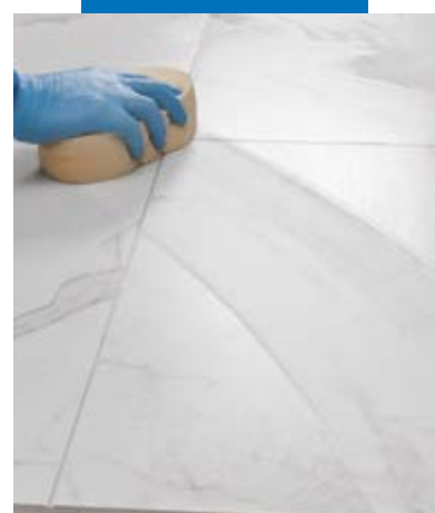
Reinigen en afwerken van voegen met een harde cellulose spons
