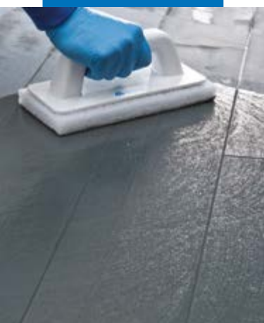
De voegen reinigen met een Scotch-Brite® spons (wanneer het product half is uitgehard)
