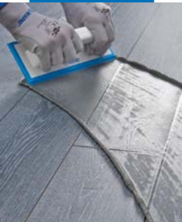
Ultracolor Plus aanbrengen met een rubber inwasbord op porseleinen vloertegels met hout-effect
