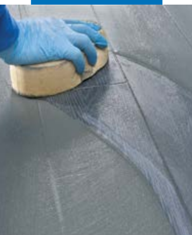
Reinigen en afwerken van voegen met een cellulose spons
