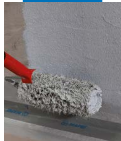
Aanbrengen van Mapegum WPS met een roller
