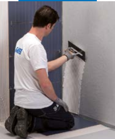
Aanbrengen van wandbekleding met Keraflex Maxi S1
