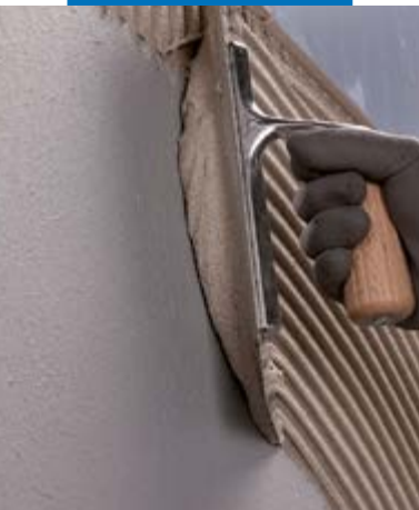
Aanbrengen van vloerbedekking met Ultramastic 5
