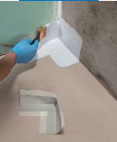
Aanbrengen van een 90° Mapeband PE 120 hoekstuk met Mapegum WPS
