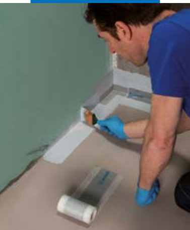
Aanbrengen van Mapeband PE 120 met Mapegum WPS
