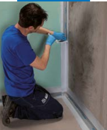
Aanbrengen van Mapeband PE 120 met Mapegum WPS
