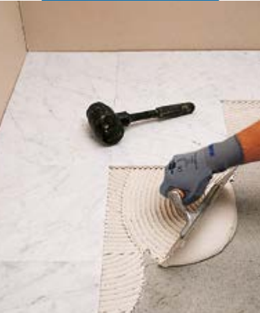
Aanbrengen van wit Carrara-marmer met Keraquick S1 wit
