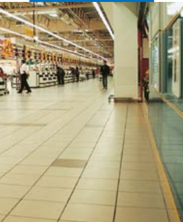
Voorbeeld van een met Keraquick S1 gelegde vloer in een Auchan-supermarkt - Sosnowiec (Polen)
