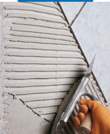
Betegelen van wanden in cellenbetonblokken
