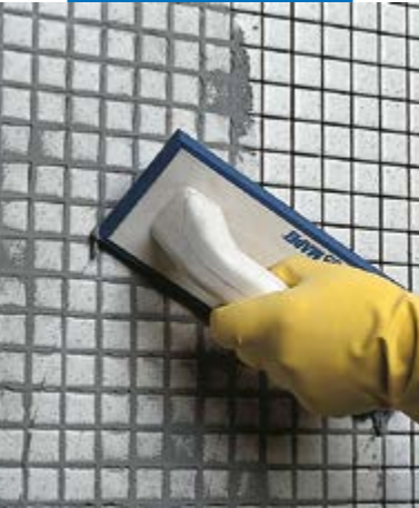
Afvoegen van glasmazaïek (badkamer) met een sponsbord
