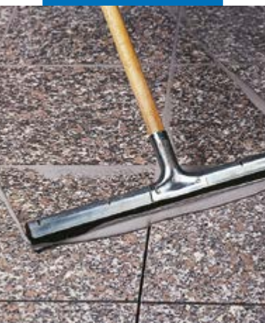
Afvoegen van een gladde, gepolijste granietvloer met een vloertrekker
