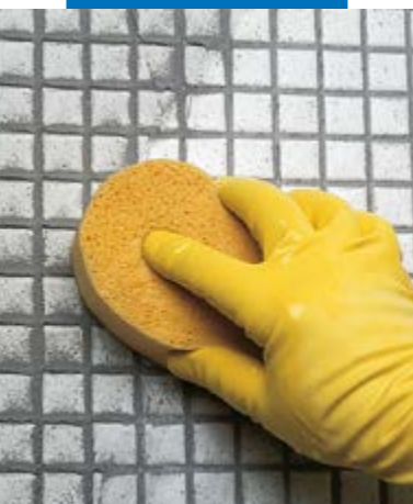
Afwerken van glasmazaïek met een spons
