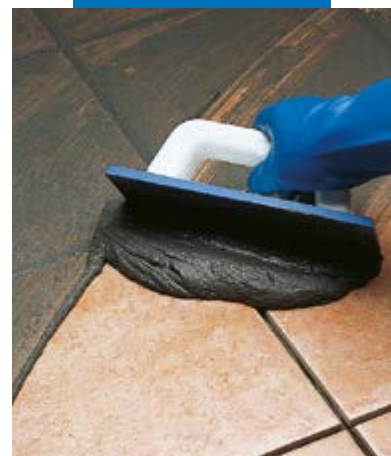
Afvoegen van enkelgebakken tegels met een sponsbord
